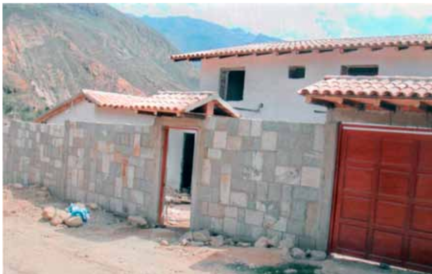
Edificio en construcción en Caraz (Ancash), propiedad de una familia limeña.
